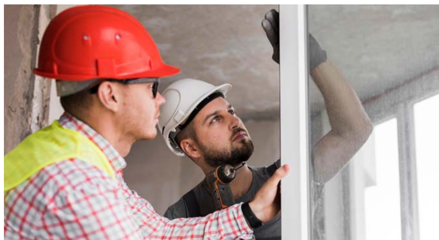
On peut ajouter ou supprimer des couloirs, des chambres ou des cloisons sans trop de dommages
