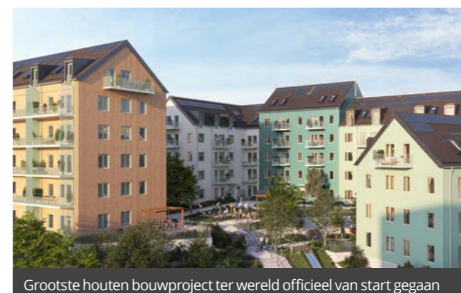
Grootste houten bouwproject ter wereld officieel van start gegaan
