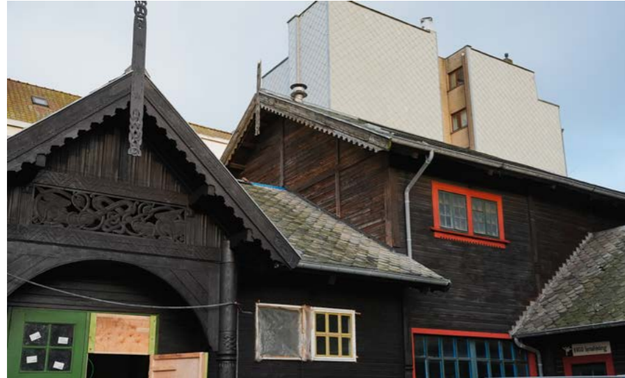
Deze foto's van voor de renovatie van het project tonen duidelijk de staat van de stallen en het hout
