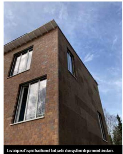
Les briques d'aspect traditionnel font partie d'un système de parement circulaire.
