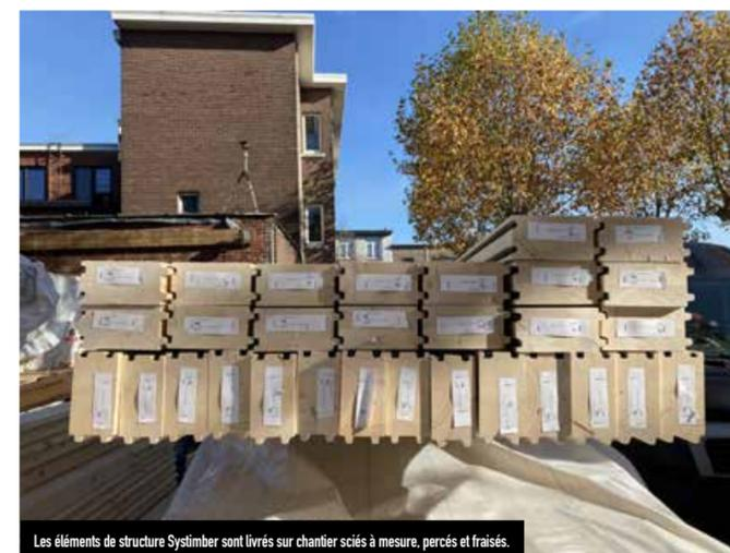
Les éléments de structure Systimber sont livrés sur chantier sciés à mesure, percés et fraisés.
