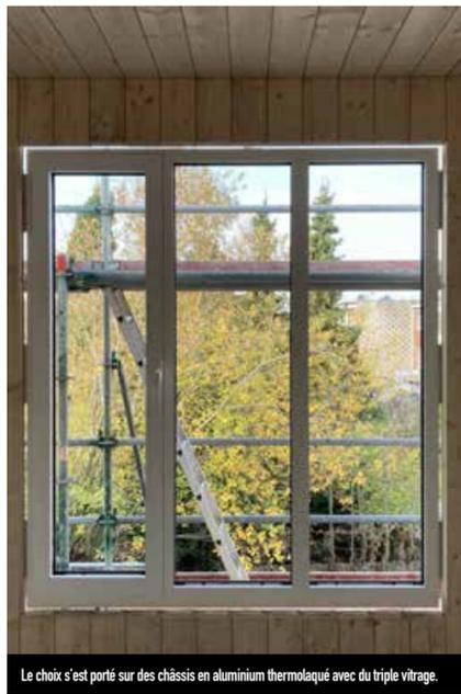
Le choix s'est porté sur des châssis en aluminium thermolaqué avec du triple vitrage.
