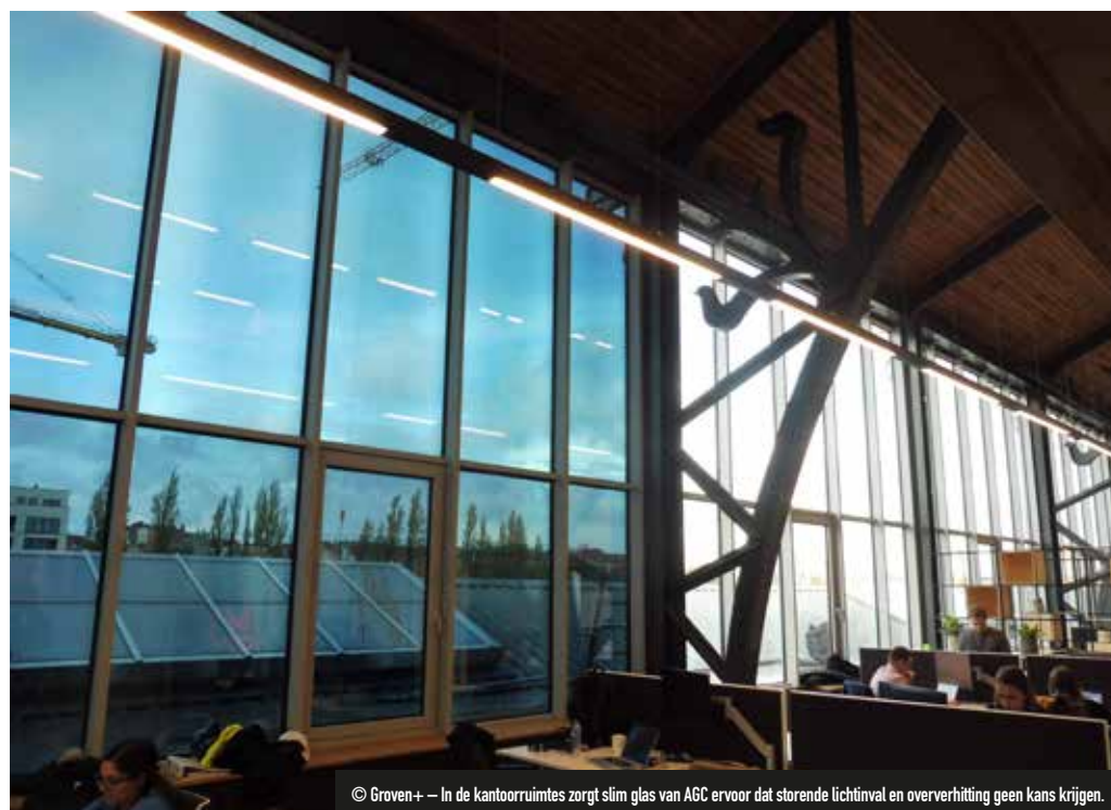
© Groven+ – In de kantoorruimtes zorgt slim glas van AGC ervoor dat storende lichtinval en oververhitting geen kans krijgen.
